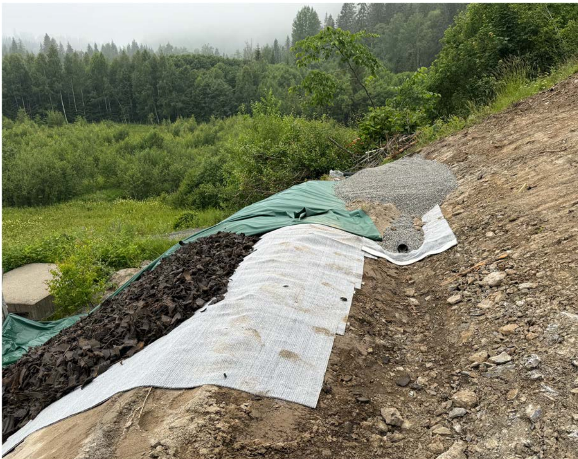
Figur 14 Bilde tatt under utlegging av membran, dekk-klipp, presenning og drengrør
