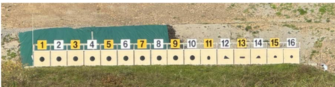
Figur 16 Ferdig tildekket kulefang sett fra standplass
