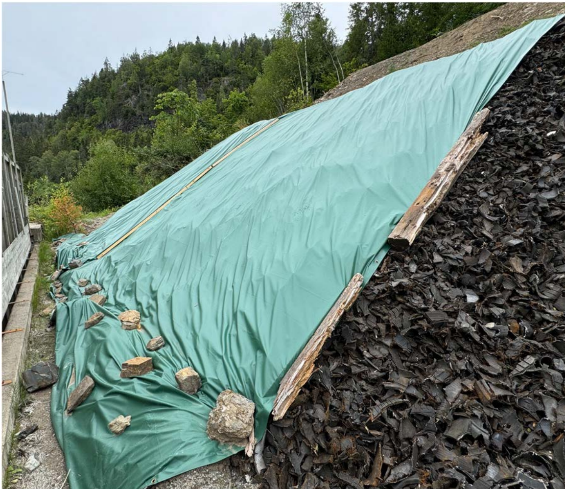
Figur 15 Steiner og trematerialer for å holde presenningen på plass
