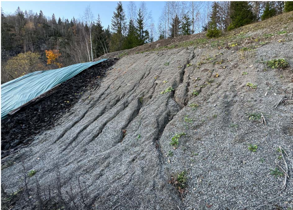
Figur 19 Erosjonsrenner etter vann på overflaten av kulefanget
