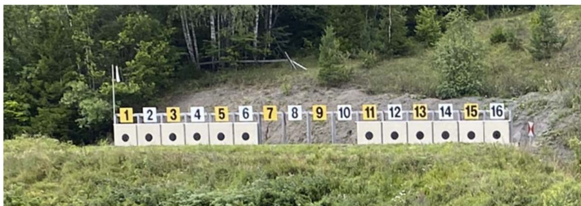
Figur 2 Kulefang av jord og sand som ligger inn mot bakgrunnen (200 m-banen til Asker skytterlag før tiltak)
