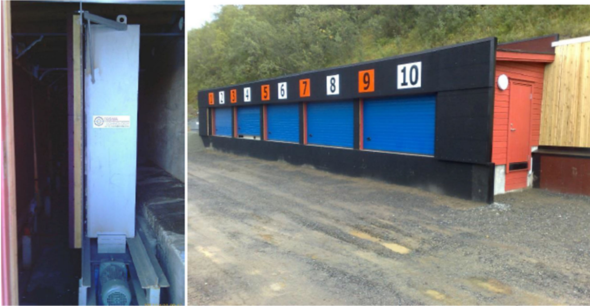
Figur 2 Lamellkulefang Trondenes leir, med en transportskrue i bunnen for utmating av kulerester. (Forsvarsbygg, 2020)
