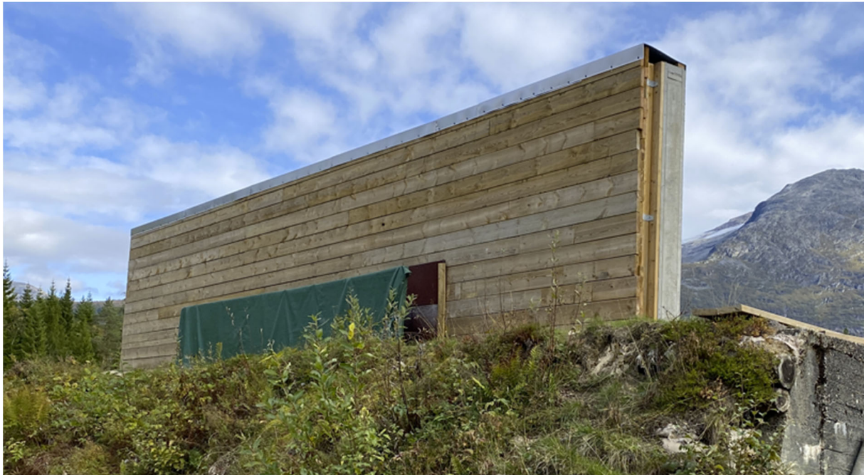
Figur 7 Kulefangvegg med innvendig vertikal stålplate og oppsamlingsrenne for kulerester (på bildet er skivene dekket av en grønn presenning)
