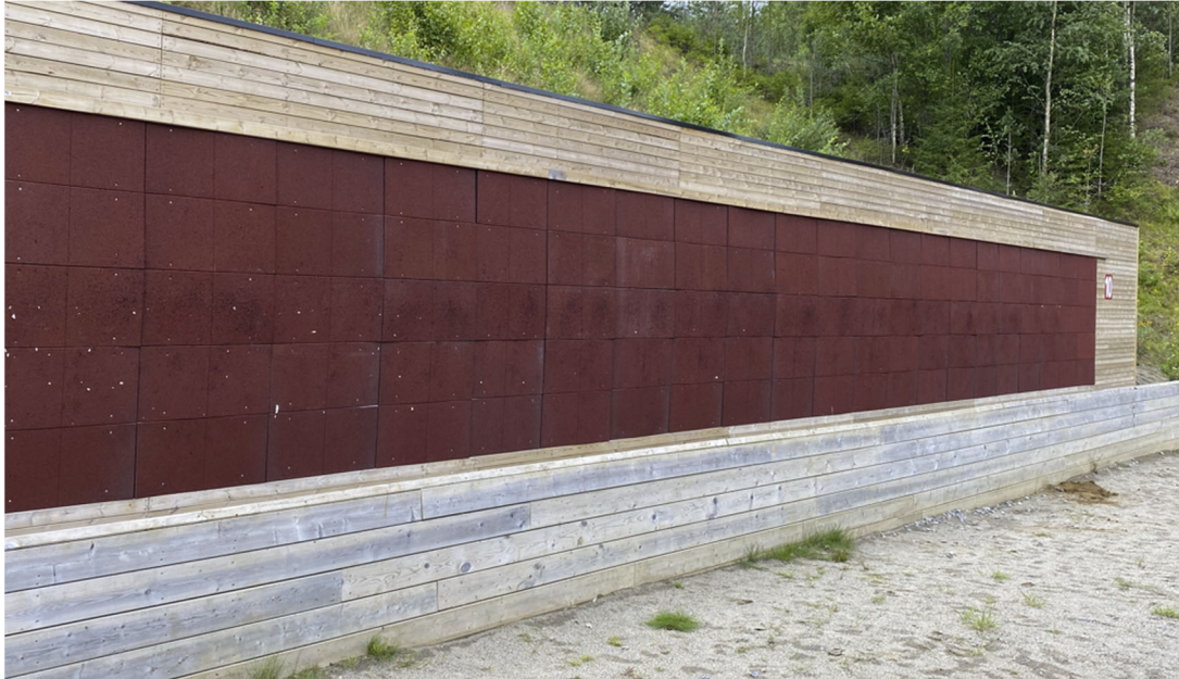
Figur 9 Kulefang med vertikal stålplate på bane 10 på Sessvollmoen
