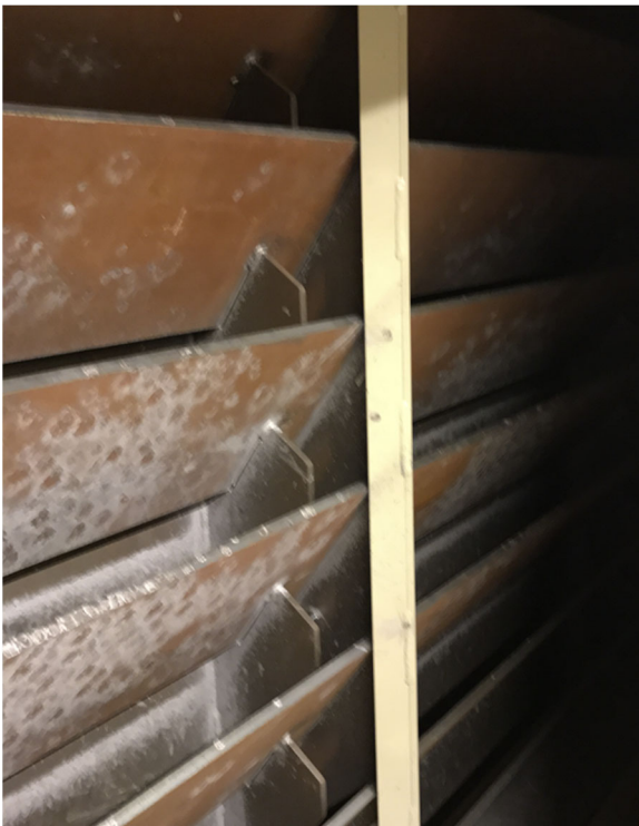
Figur 3 Stållameller i kulefang. Både lamellene og bakplaten er av Hardox stålblater
