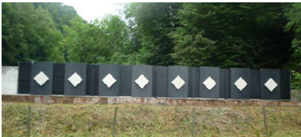
Figur 4 Kulefangerkassetter med innvendige stålplater. Leu & Helfenstein AG
