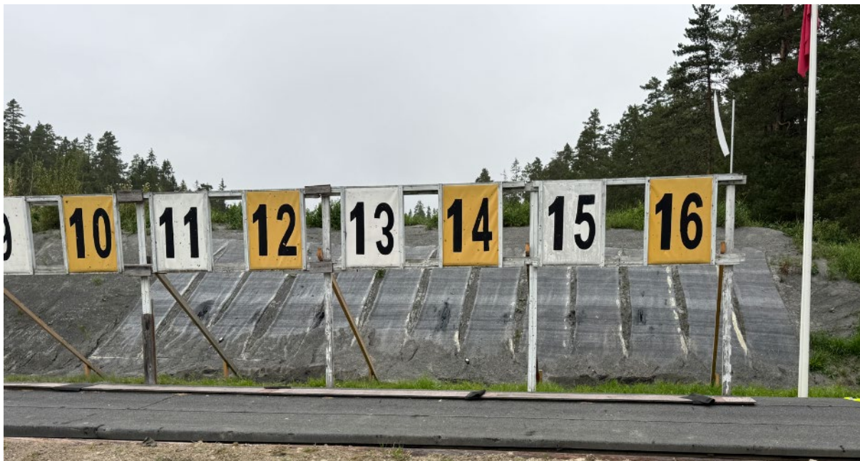
Figur 14 Krympet bentonittmembran
