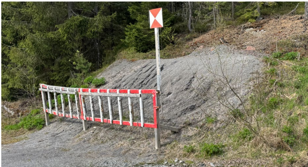
Figur 7 Rælingen skytterlags 100 m-bane med pappskivestativ før tiltak
