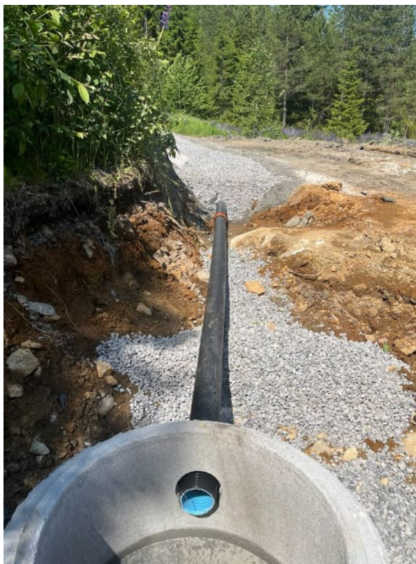
Figur 37 Prøvetakingskummen i forgrunnen og drensgroften i bakgrunnen
