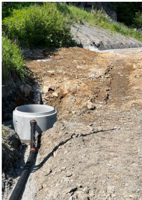
Figur 38 Filterkummen med rør til bekk for rensset vann. Prøvetakingskummen og kulefanget i bakgrunnen
