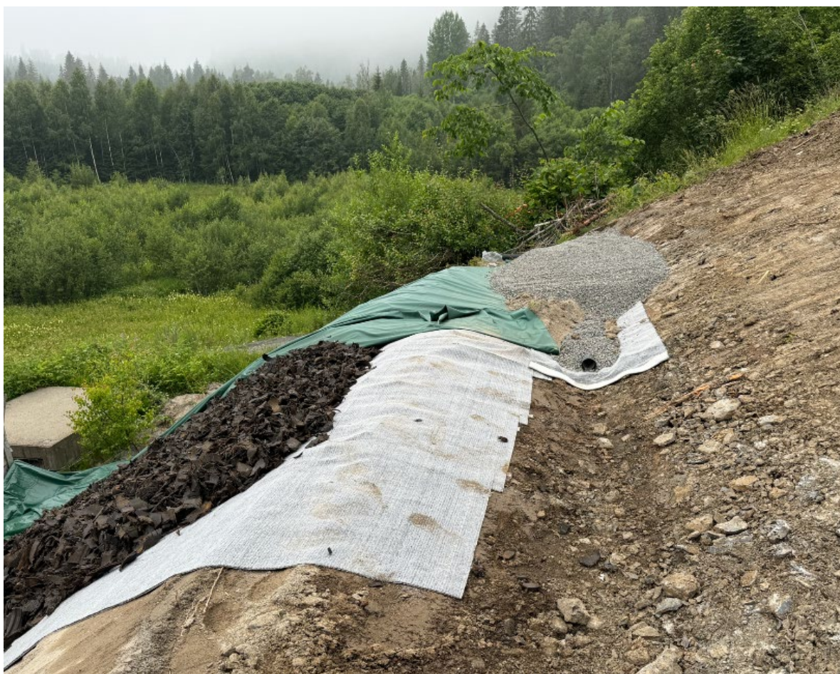
Figur 22 Bilde tatt under utlegging av membran, dekk-klipp, presenning og drengroft
