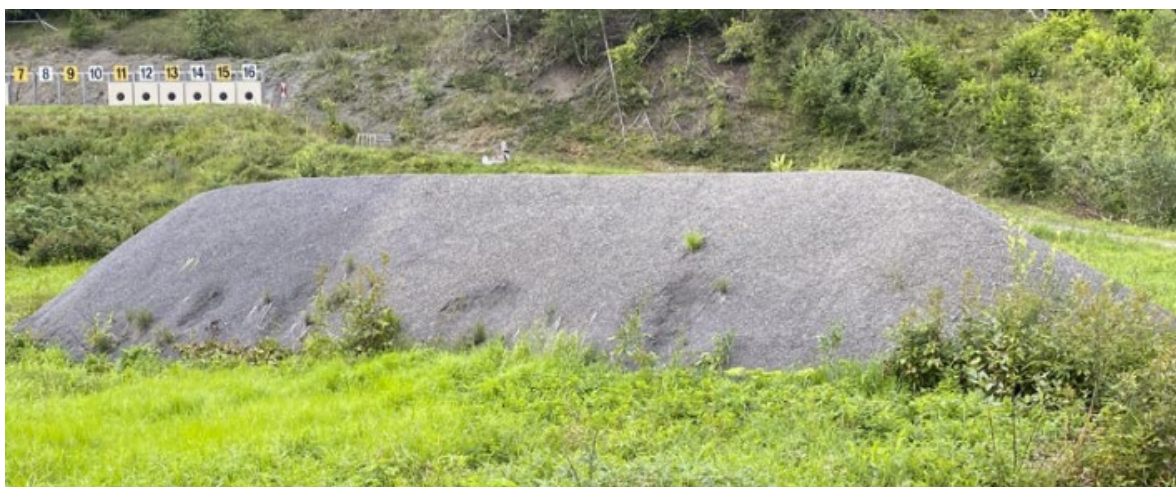
Figur 3 Kulefang av jord og sand i form av frittliggende voll på Asker skytterlags bane
