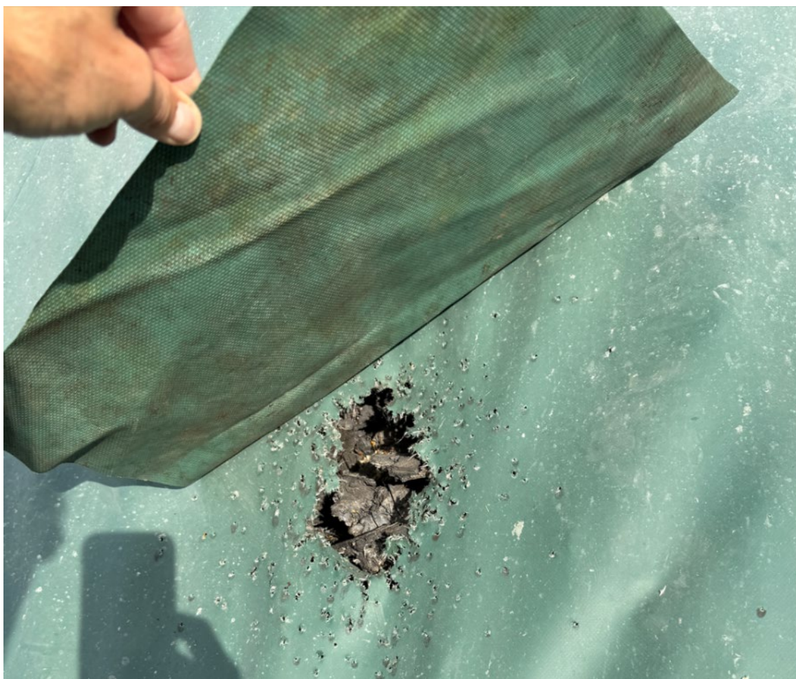
Figur 11 Asker skytterlag - Lapp over hull i duken
