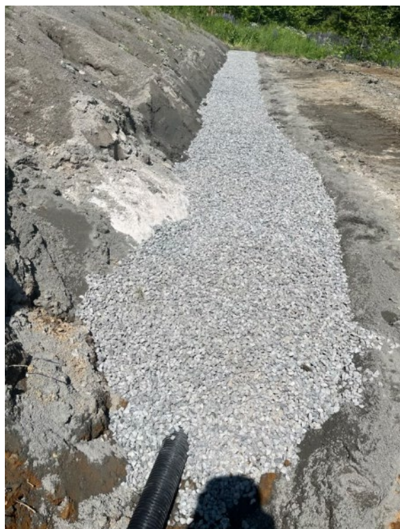
Figur 35 Pukk fylt rundt drenerørret
