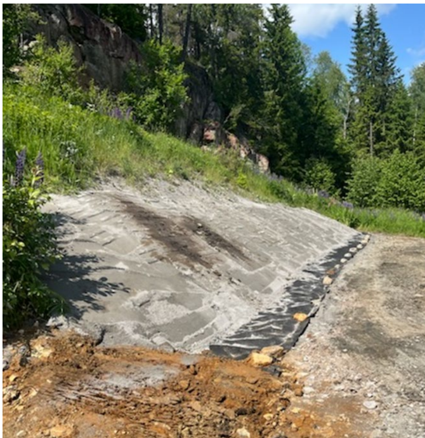
Figur 36 Kulefanget ferdig, og fiberduken er lagt på pukken i grøften
