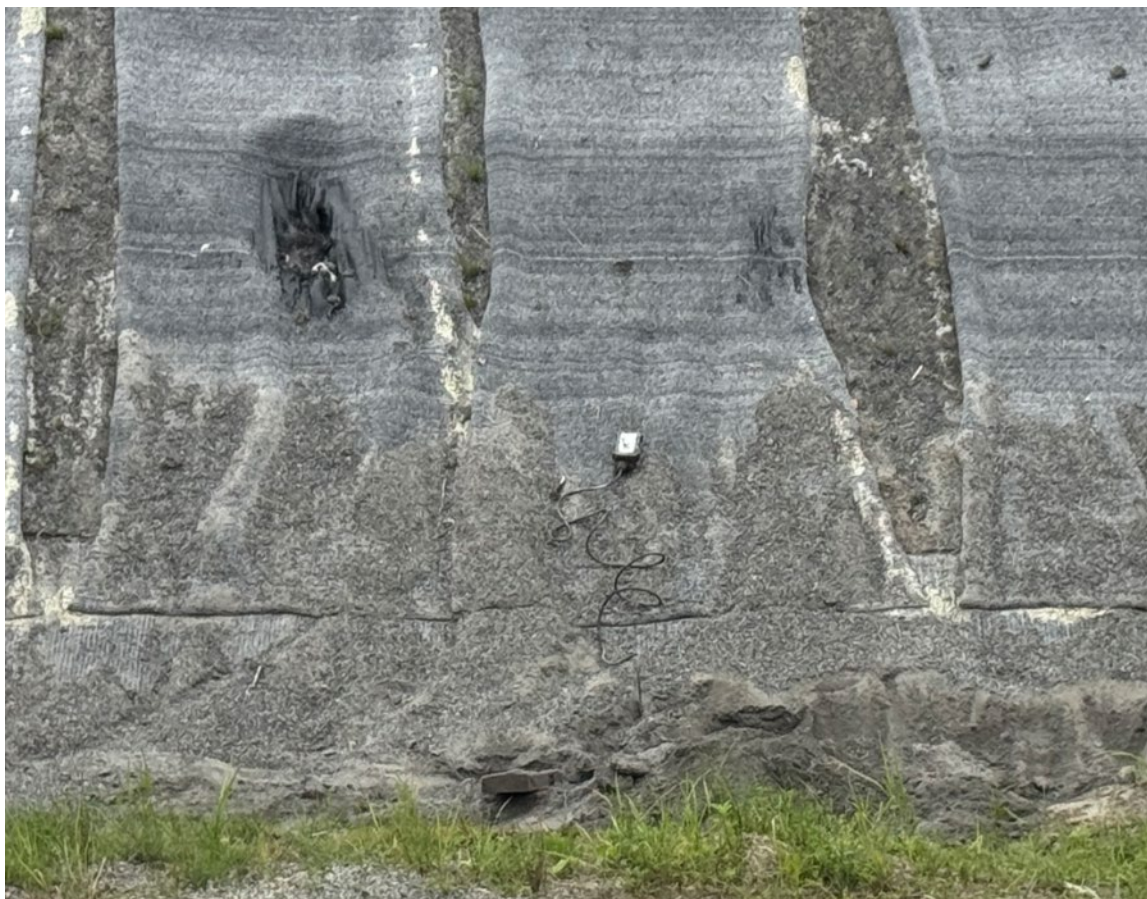
Figur 15 Krympet membran, utvasket grus og senderen til fuktsensoren gravet frem
