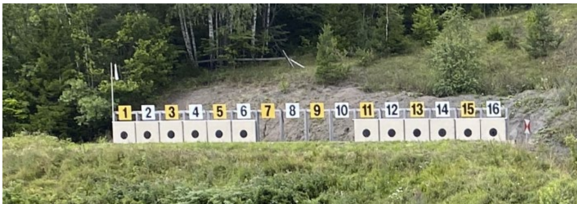
Figur 2 Kulefang av jord og sand som ligger inn mot bakgrunnen på 200 m-banen til Asker skytterlag (før tiltak)
