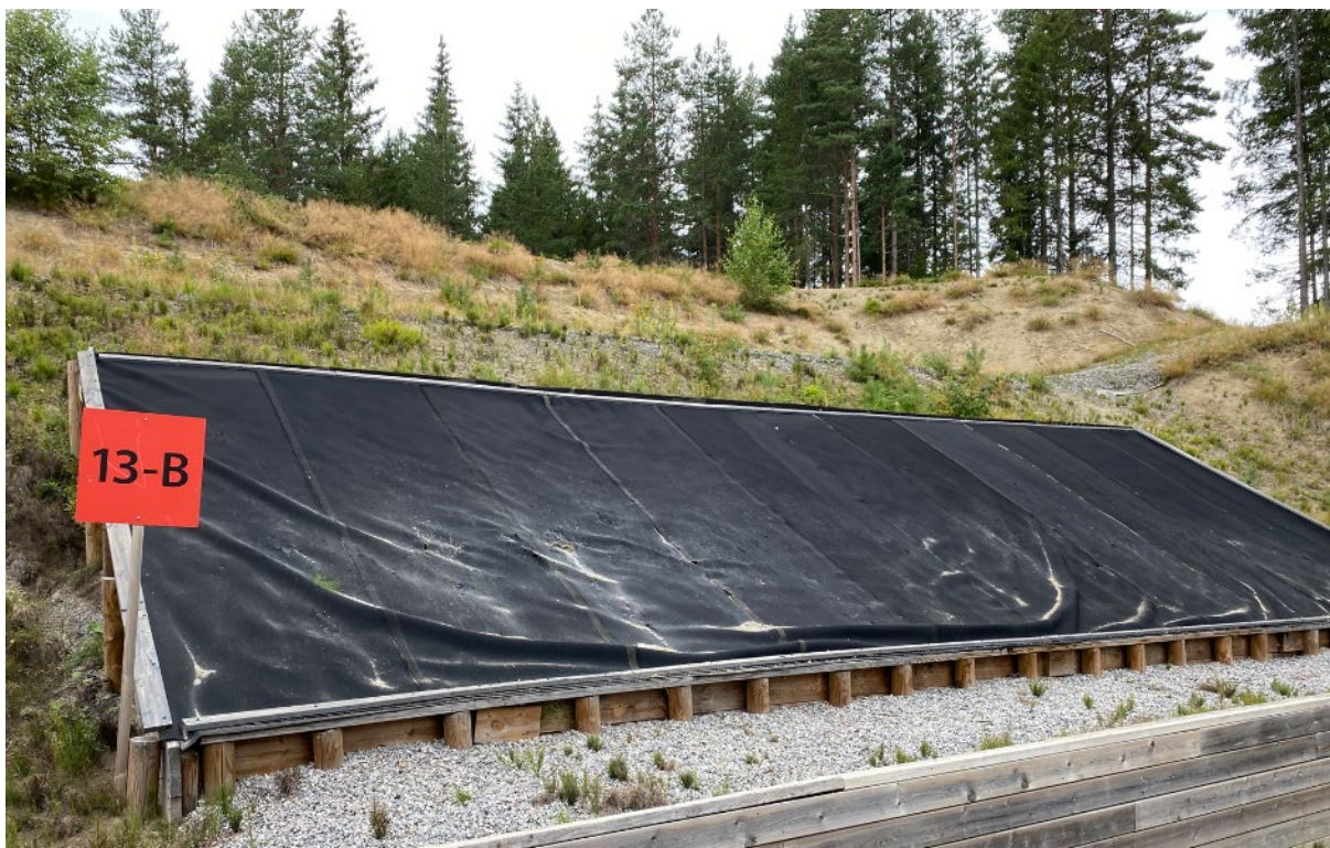
Figur 5 Bane 13-B på Sessvollmoen. Sandkulefang dekket med gummiduk.
