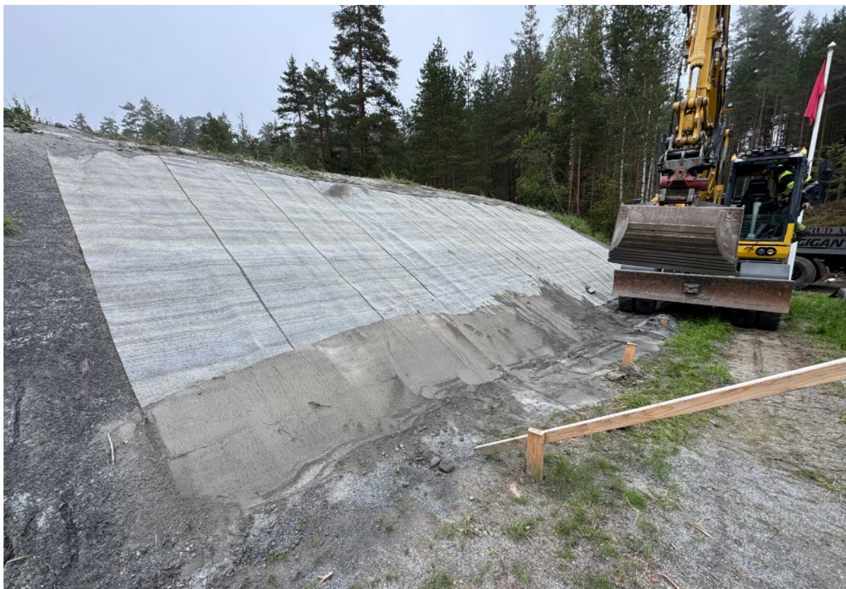
Figur 16 Utbedret tildekking med ny bentonittmembran.
