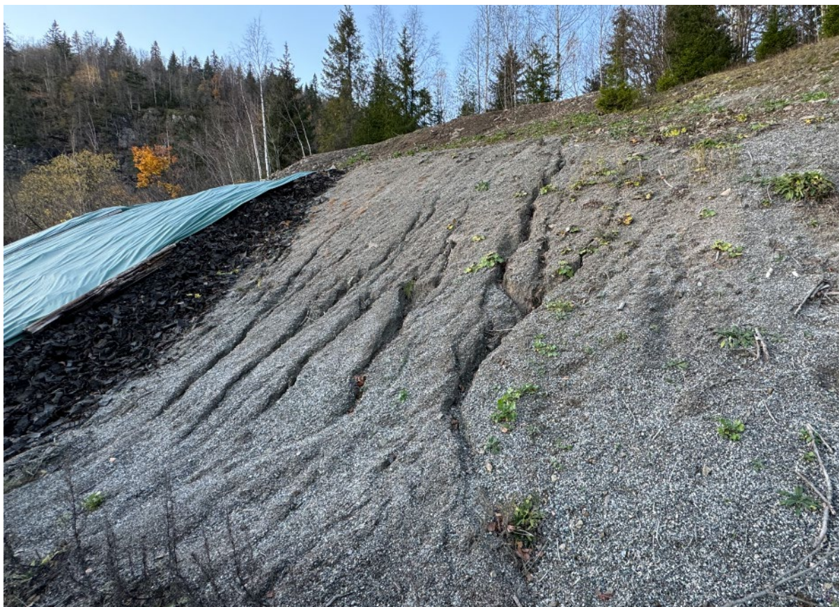
Figur 45 Erosjonsrenner etter vann på overflaten av kulefanget på 200 m-banen til Asker skytterlag
