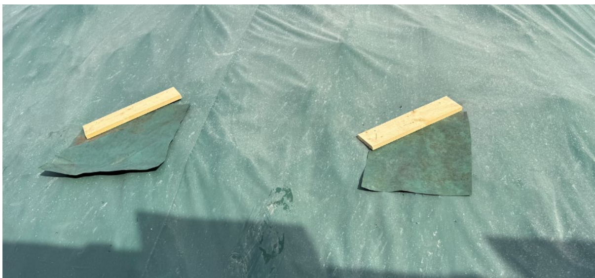
Figur 10 Asker skytterlag - Vann-avvisere og lapping av duk
