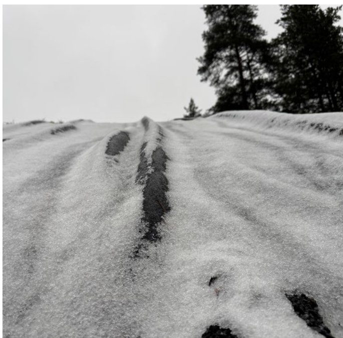
Figur 19 Nærbilde av buklete membran på kulefanget, tatt nedenfra
