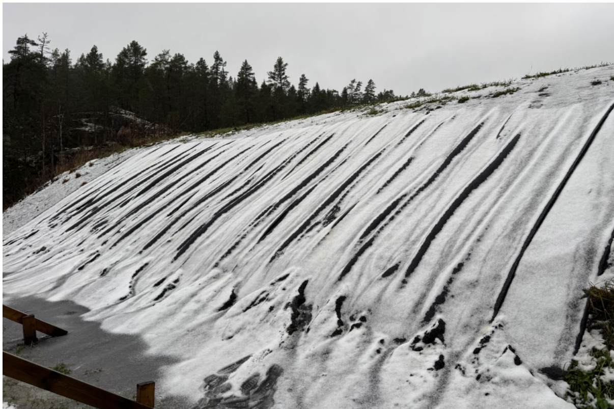
Figur 18 Bentonittmembran på 200 m kulefang i november 2025
