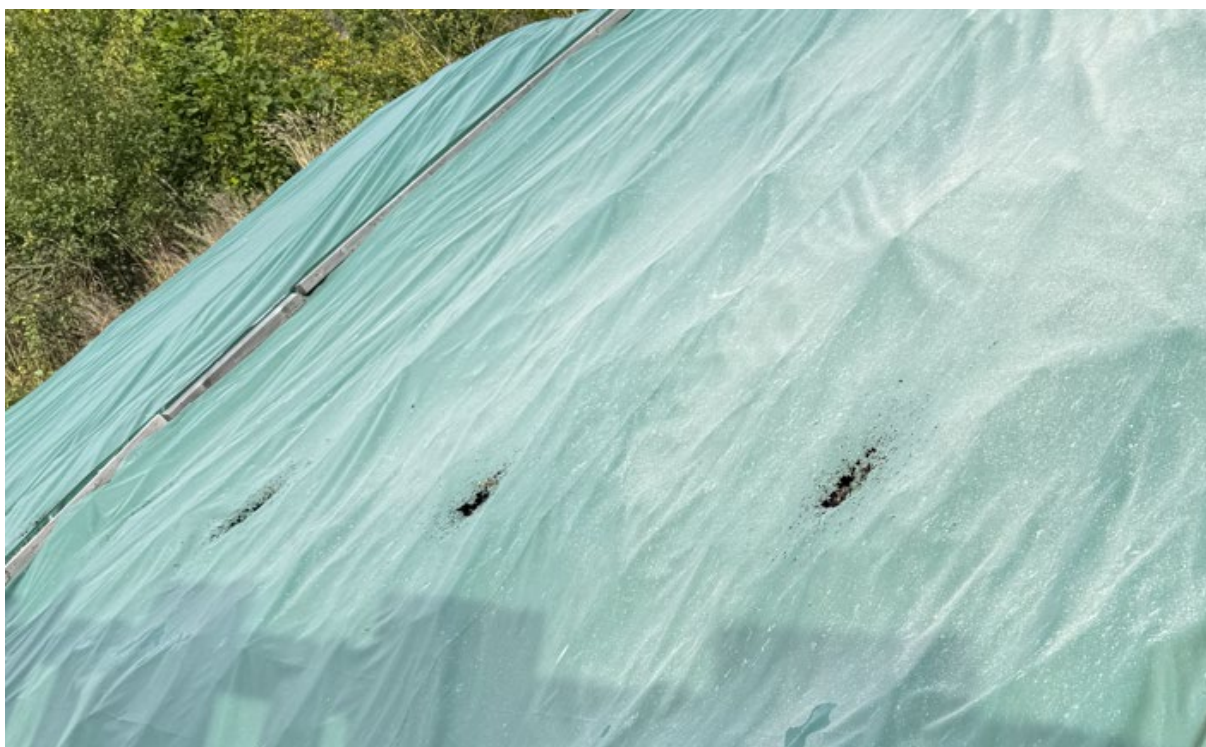
Figur 9 Asker skytterlag - konsentrerte hull på 200 m-banen
