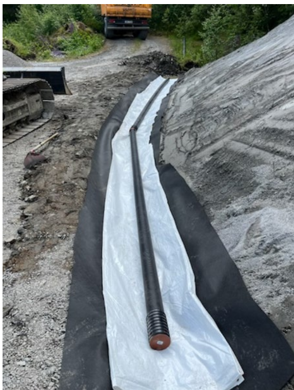
Figur 34 Grøft med bunntetting og drenerør
