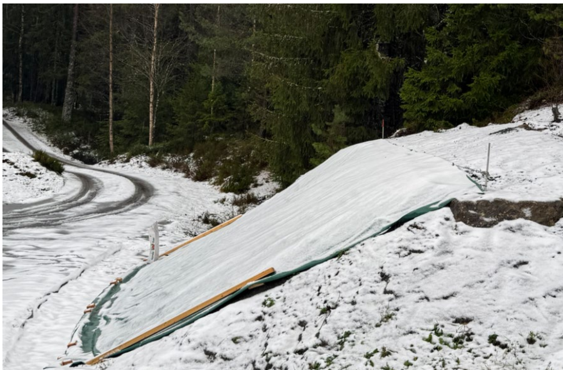
Figur 31 Grøften fryser til is etter noen dager med sludd.
