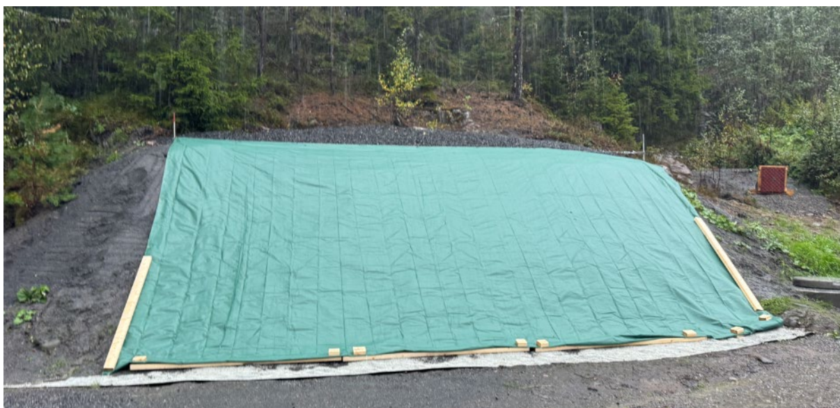
Figur 8 Rælingen skytterlags bane – tildekking med PVC-presenning før nytt skivestativ var montert
