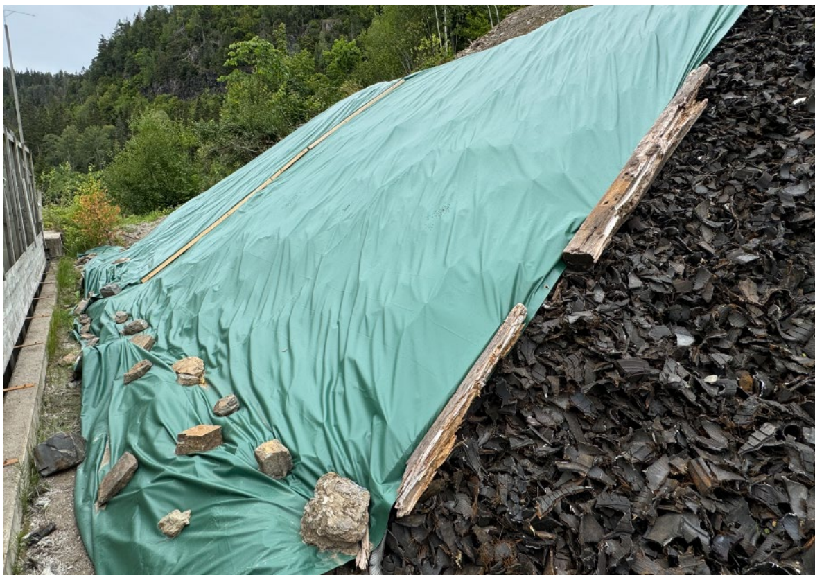
Figur 23 Steiner og trematerialer for å holde presenningen på plass
