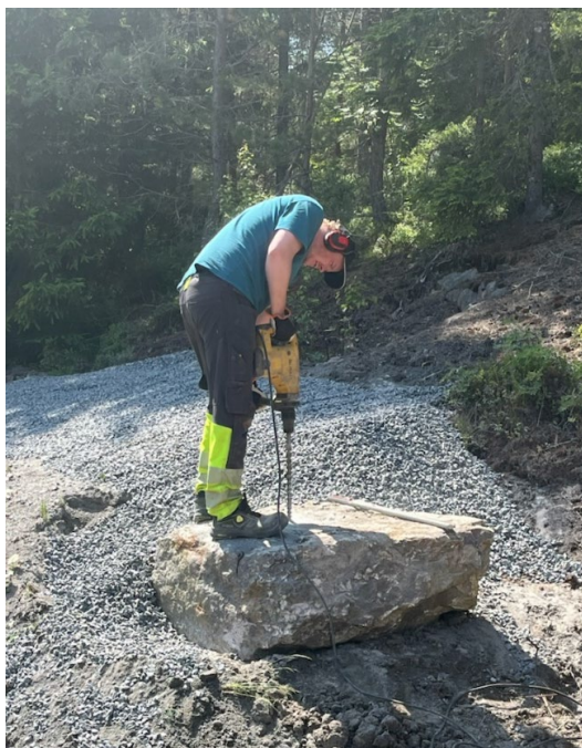
Figur 28 Boring av hull for feste av wire til presenning. Finpukk i grøften over drenerøret i bakgrunnen
