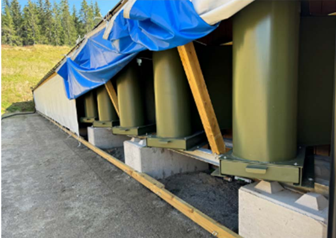
Figur 9 Kulefangerne sett bakfra etter at taket er forlenget
