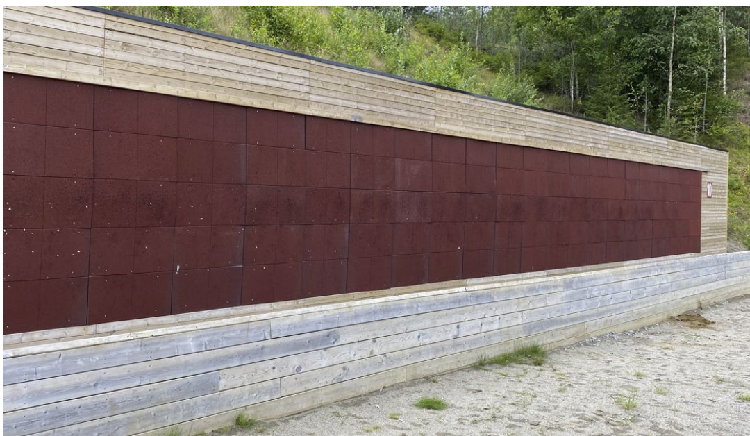
Figur 27 Kulefang med vertikal stålplate på bane 10 på Sessvollmoen
