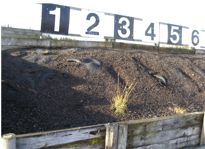
Figur 8 Nærbilde av kulefang med kasse av tre-stolper og tre-bjelker for å holde på jord/sand i kulefanget
