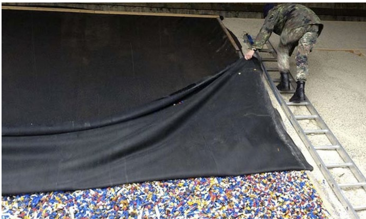
Figur 12 Plastgranulat-kulefang med duk over. Hentet fra https://www.obsima.no/produkter/skyte-og-ovingsanlegg/rikosjettsikring/sgp-rutec-r5000-granulat
