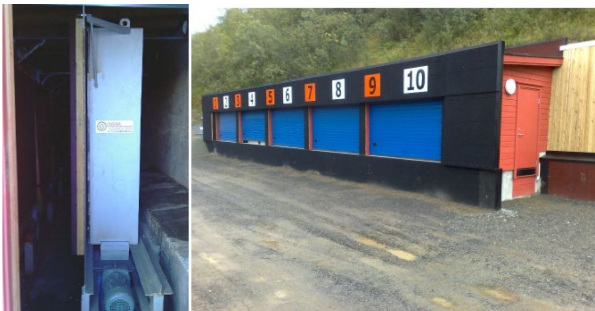
Figur 20 Lamellkulefang Trondenes leir, med en transportskrue i bunnen for utmating av kulerester. (Forsvarsbygg, Håndbok for skyte- og øvingsfelt 2020 - 2022, 2020)
