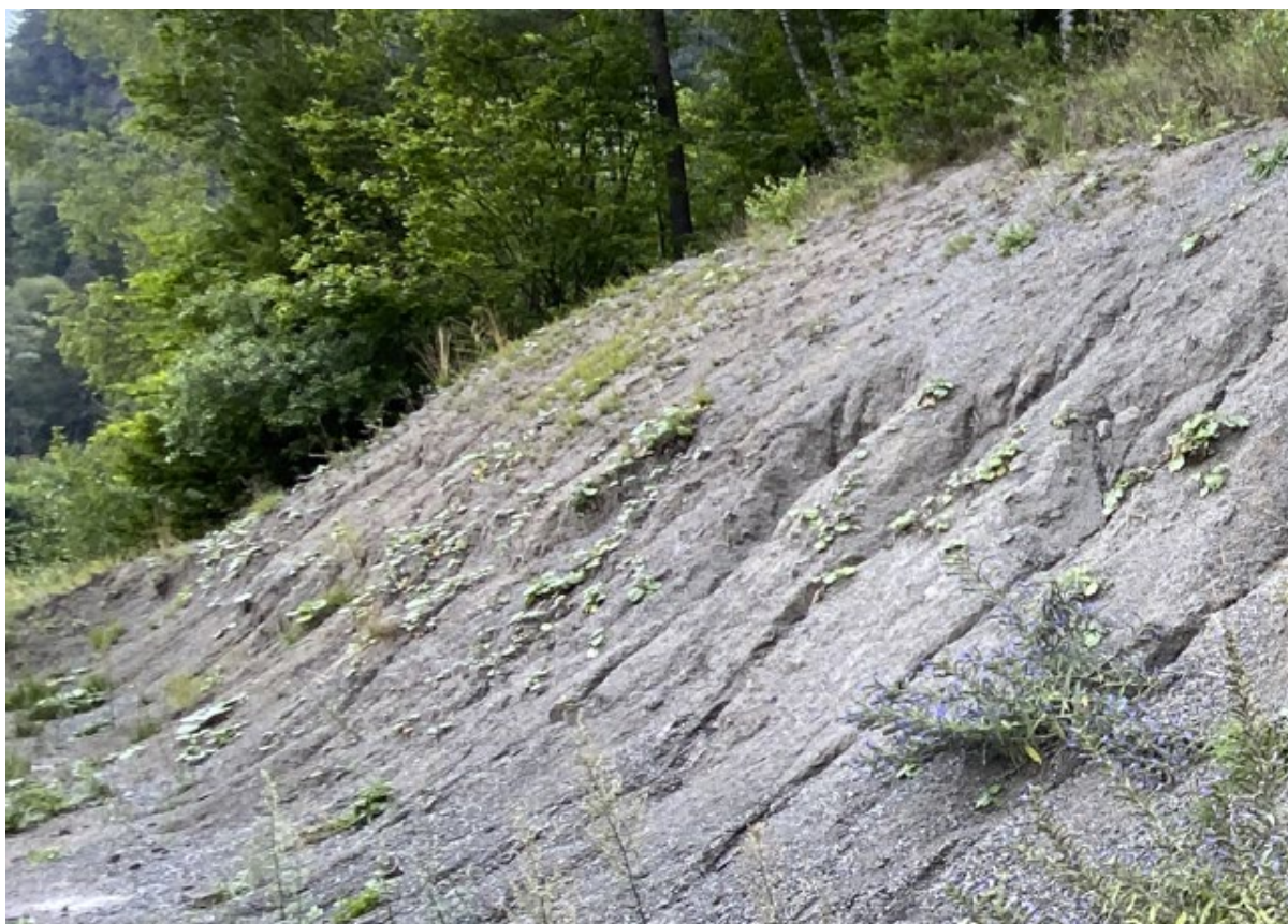
Figur 6 Eksempel på gropdannelser i del av kulefang med grus (nærmest) og mindre grad av gropdannelse i del av kulefang med jord (lengst bort)
