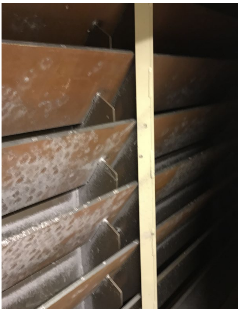
Figur 21 Stål-lameller i kulefang. Både lamellene og bakplaten er av Hardox stålplater
