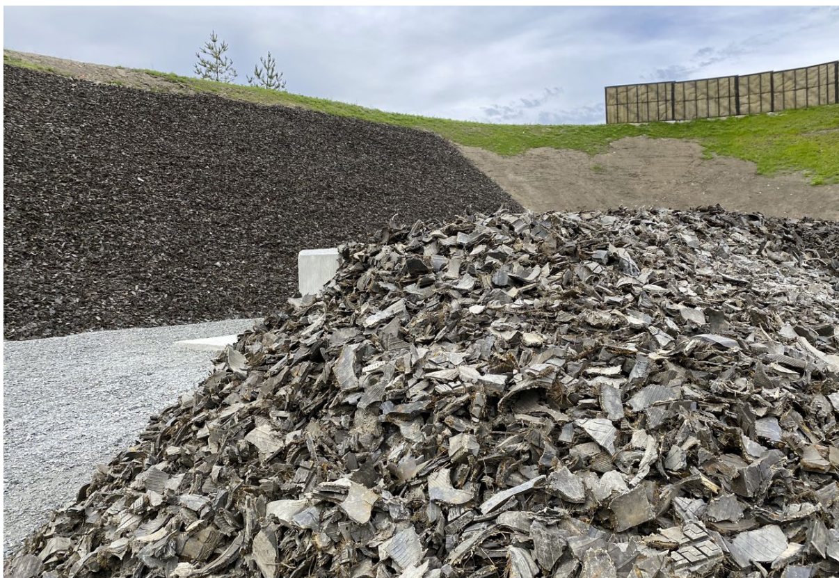
Figur 15 Skivevoll og kulefang av dekk-klipp sett fra siden
