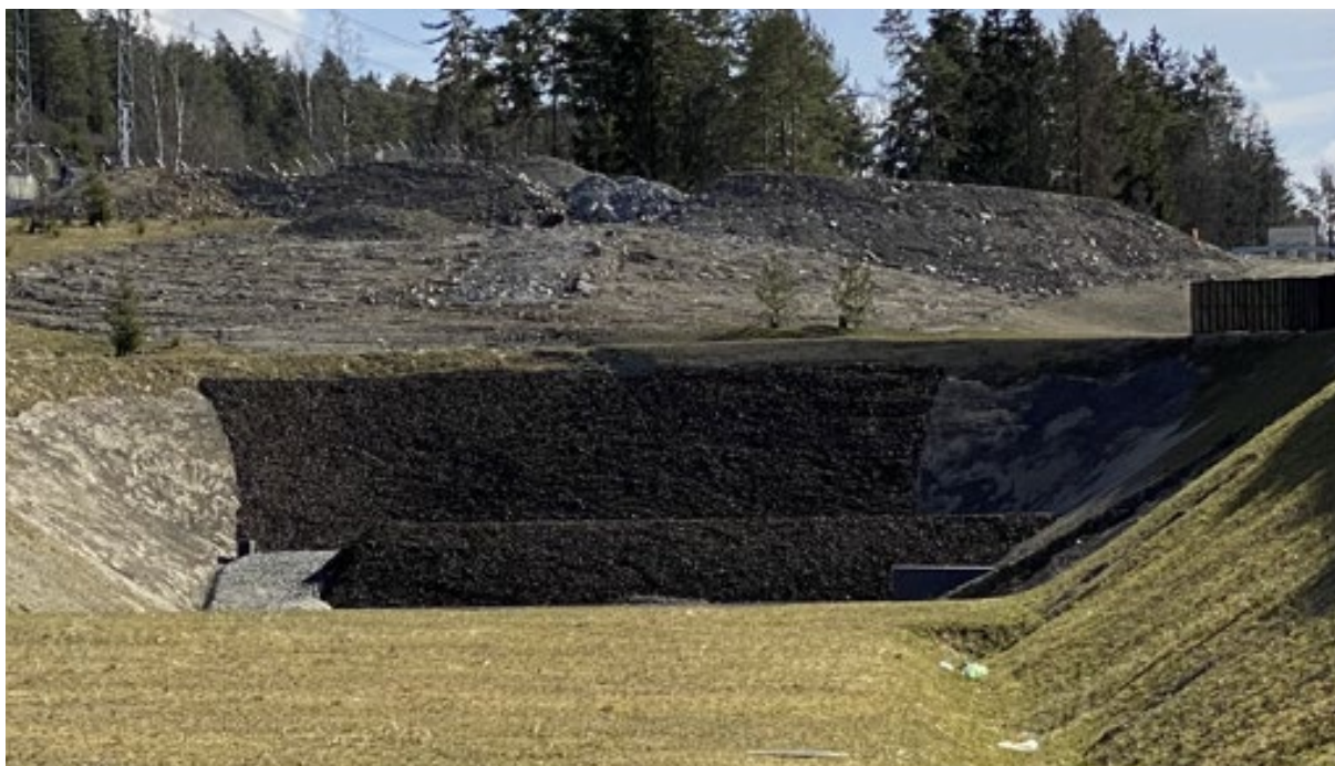
Figur 14 Skivevoll og kulefang av dekk-klipp sett fra standplass
