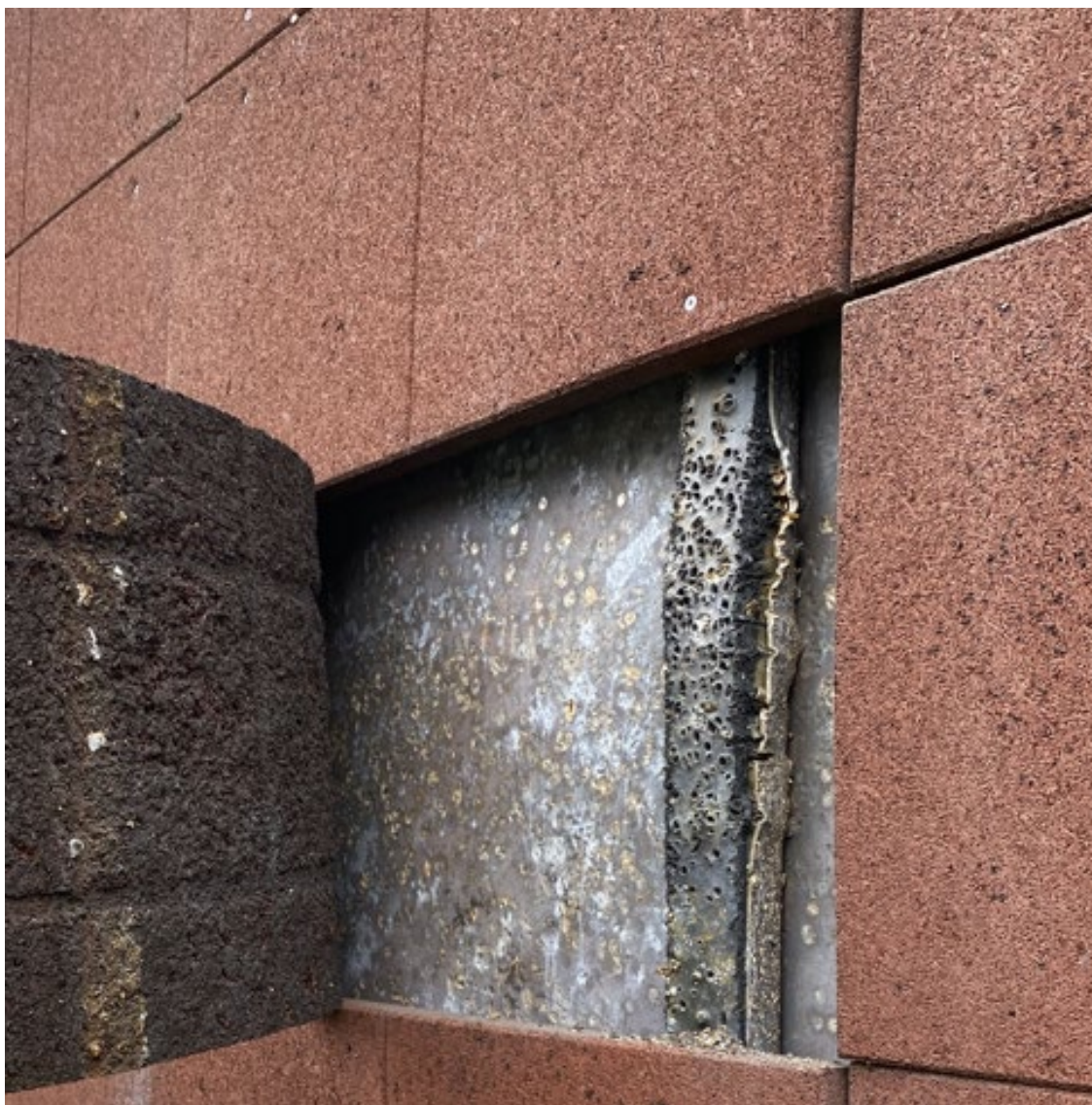
Figur 29 Bilde som viser innsiden av kulefanget på bane 10 på Sessvollmoen
