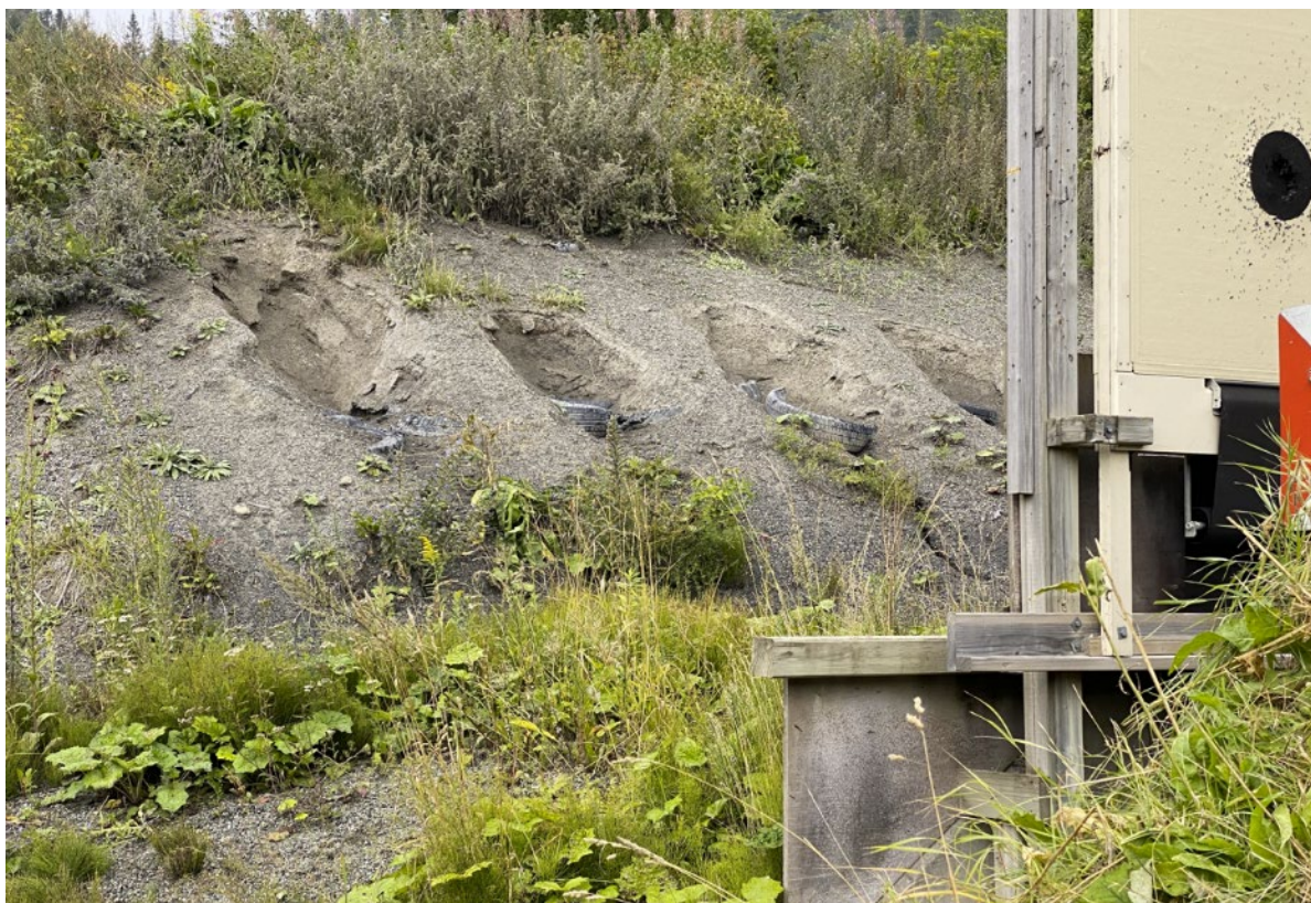
Figur 5 Eksempel på bildekk i kulefang som forsøk på å stabilisere massene
