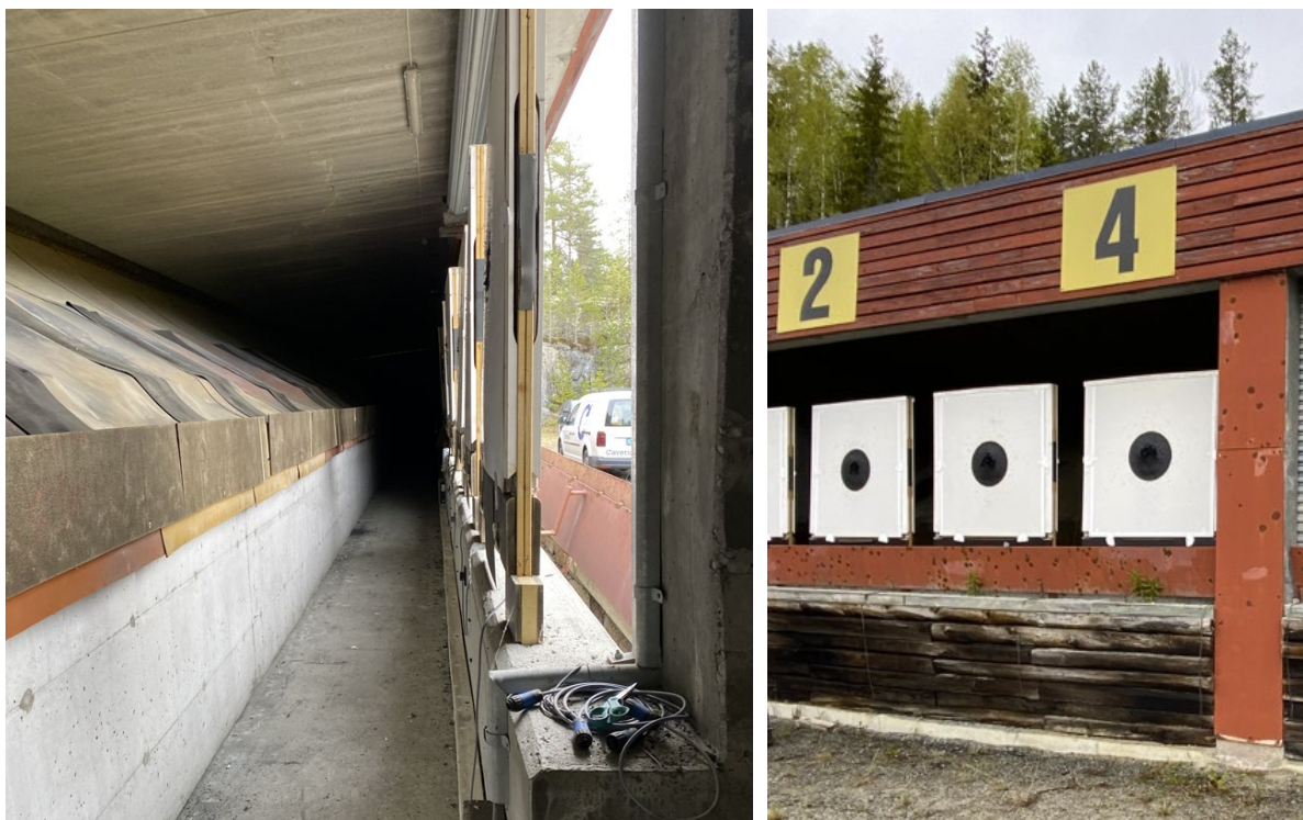
Figur 13 Skrått granulatkulefang med duk og tak over, på Ringerike Skytesenter
