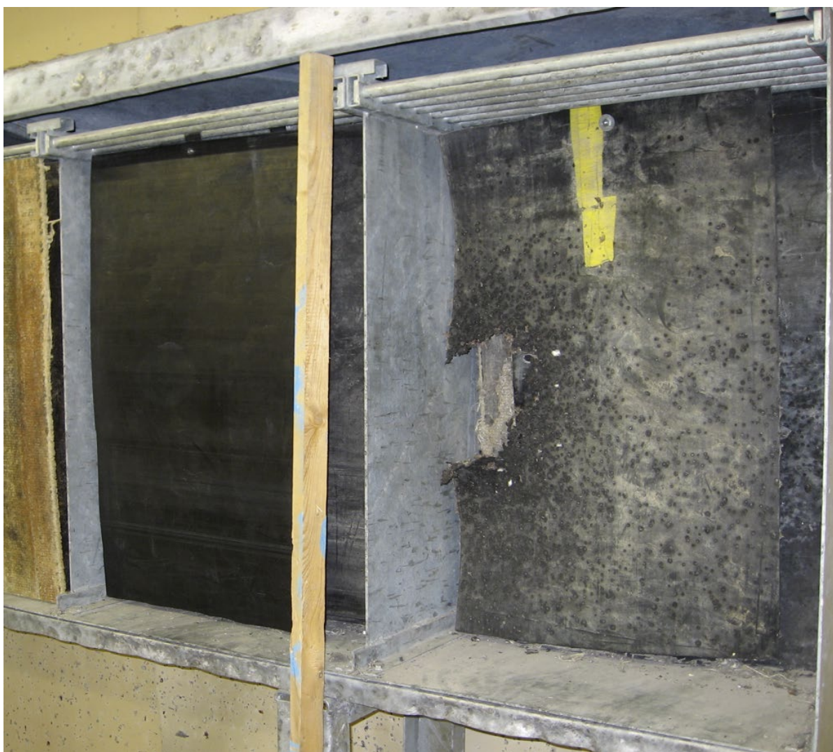
Figur 17 Stålkasse med hengende lameller av transportbånd. Brünig Indoor i Sveits
