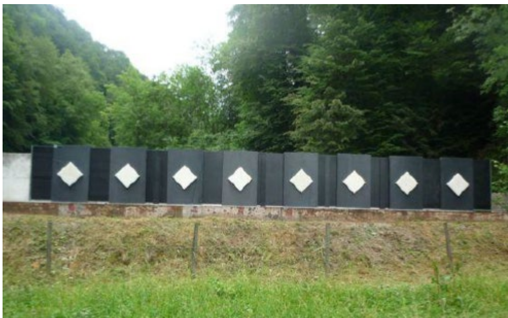
Figur 22 Kulefangerkassetter med innvendige stålplater. Leu + Helfenstein AG (Sveits)
