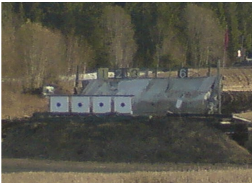
Figur 7 Kulefang bygget opp med kasse av tre-stolper og tre-bjelker
