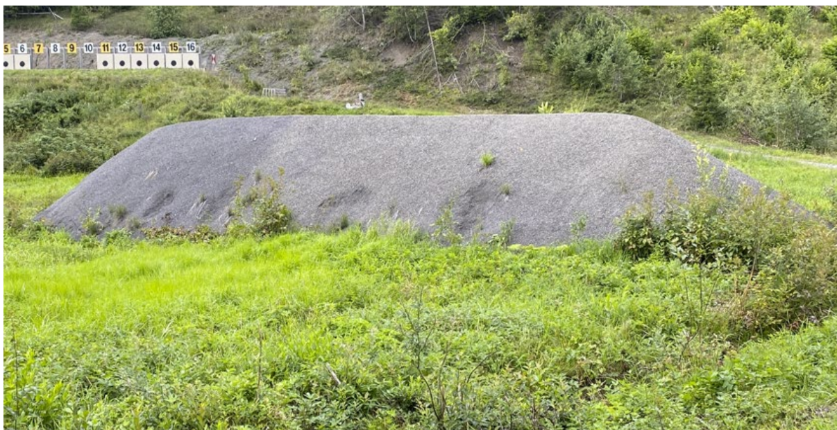
Figur 3 Kulefang som frittliggende voll, her for Stang- og felthurtigskiver
